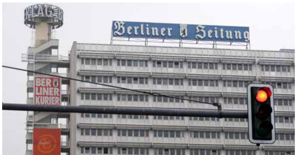
Das Verlagsgebäude am Alexanderplatz in Berlin.
