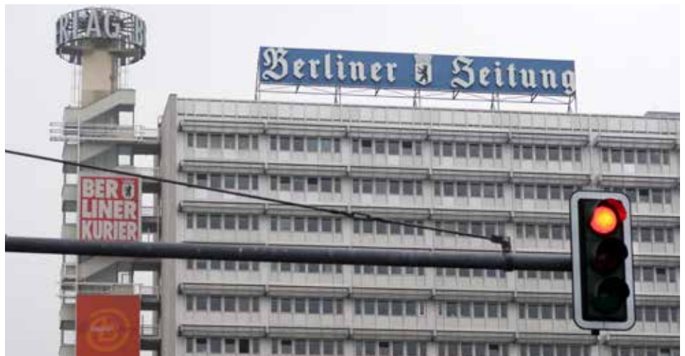
Das Verlagsgebäude am Alexanderplatz in Berlin.
